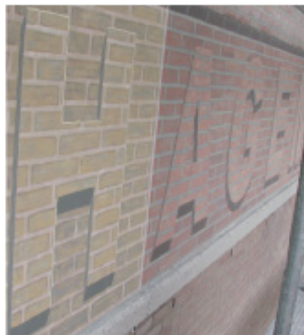
De naam van de flat wordt nu op een speciaal voor dat doel gestucte ondergrond geschilderd. Het kleurverschil in de bestaande baksteen wordt gevolgd
