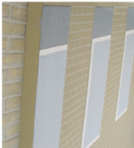
Voor de schildering zijn gevelisolatieplaten aangebracht. De steenkleur wordt precies nagebootst. Er wordt tamelijk precies geschilderd
