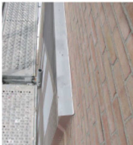
De gevelisolatieplaten zijn vakkundig door aannemer Heijmans aangebracht. Nadat de gevel grondig gereinigd en plaatselijk gerepareerd was
