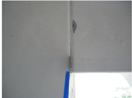
Open kozijnverbinding aan de binnenzijde.
