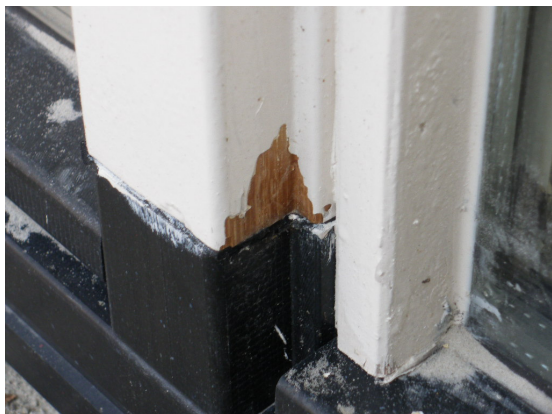
Afbladderen totale verfsysteem bij aansluiting neut.
